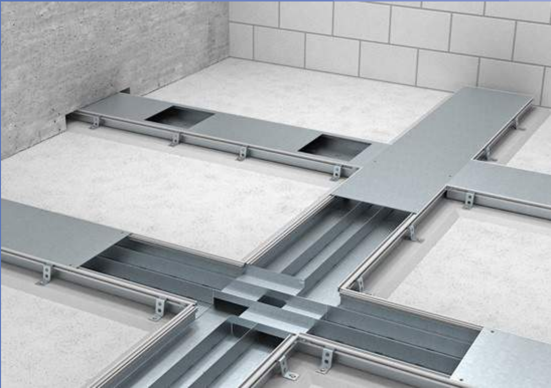
ترانکینگ زمینی قابل دسترس - قبل از اتمام کار
